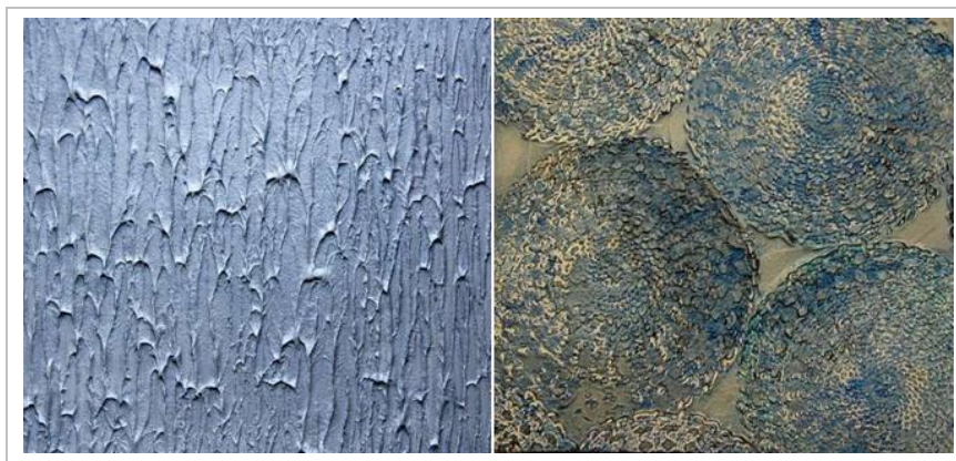
Rysunek 5.2 Zastosowanie farby emulsyjnej strukturalnej
