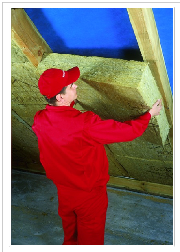
Rysunek 5.6 Montaż materiału izolacyjnego między krokiewmi
