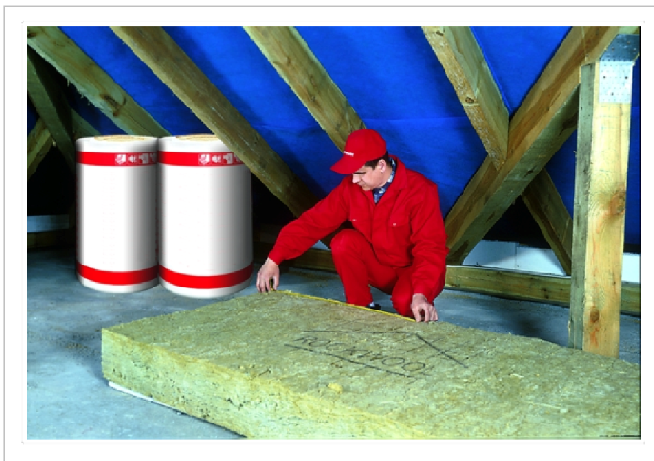
Rysunek 5.5 Docięcie materiału izolacyjnego
