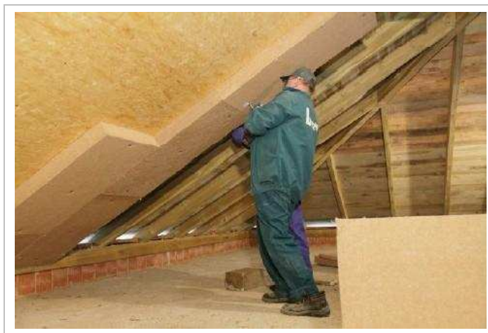
Rysunek 5.8 Montaż izolacji podkrokwiowej
