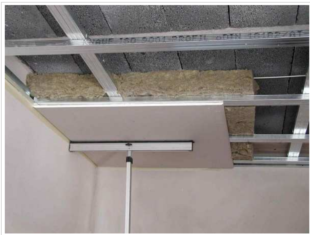
Rysunek 5.2 Izolacja sufitu podwieszanego
