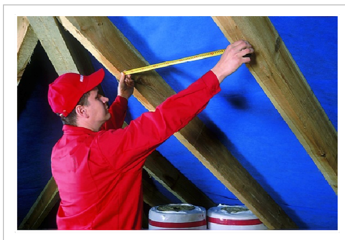
Rysunek 5.4 Pomiar odległości między krokwiemi
