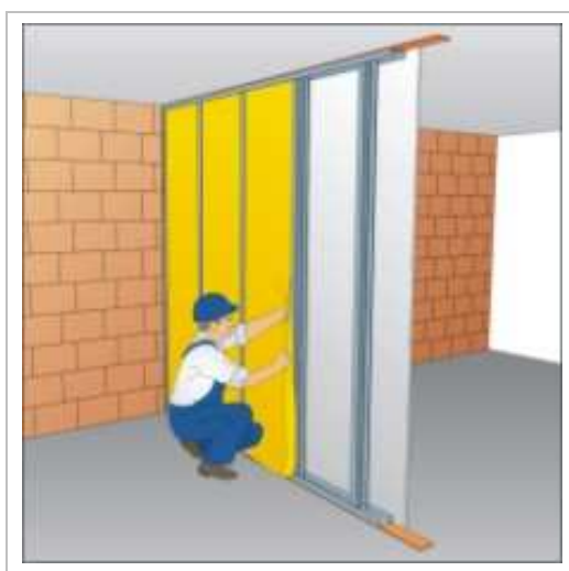
Rysunek 7.5 Układanie izolacji Źródło: www.budnet.pl
