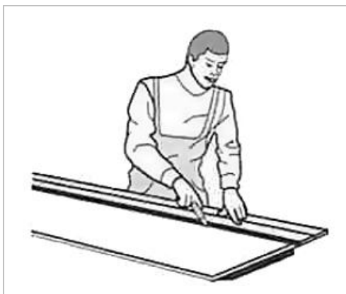
Rysunek 1.1 Nacinanie nożem płyty gipsowo-kartonowej
