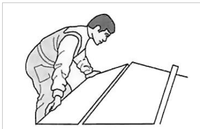
Rysunek 1.2 Łamanie pociętej płyty gipsowo-kartonowej
