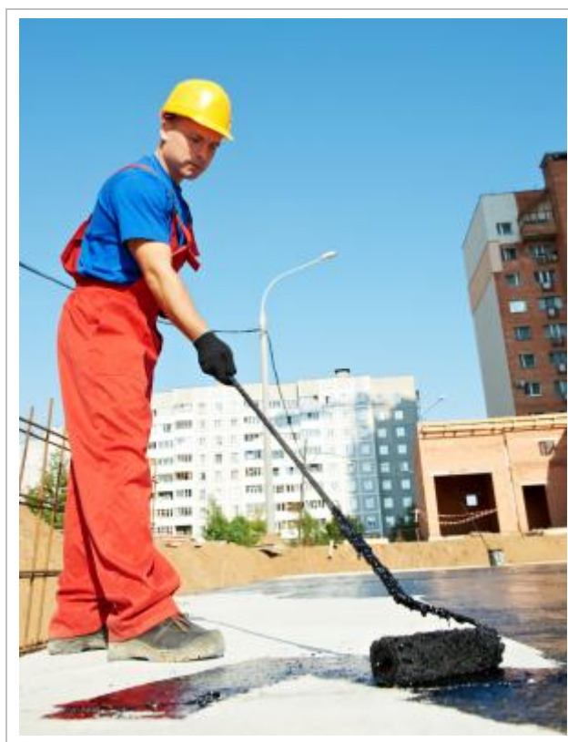
Rysunek 2.1 Pracownik nakładający izolację przeciwwilgociową
