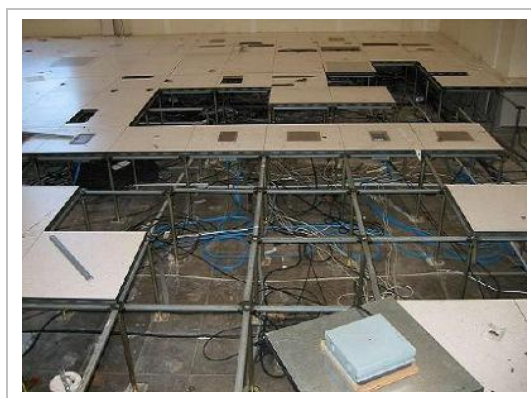
Rysunek 4.8 Podłoga podniesiona w serwerowni
