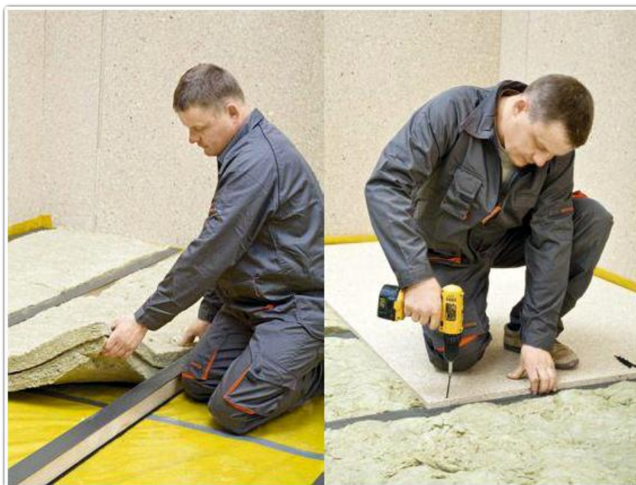
Rysunek 5.3 Konstrukcja z legarów
