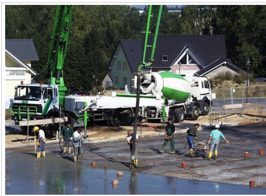
Rysunek 7.14 Pompa do betonu
