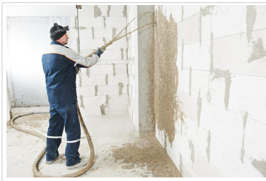
Rysunek 6.1 Obrzutka wykonywana mechanicznie
