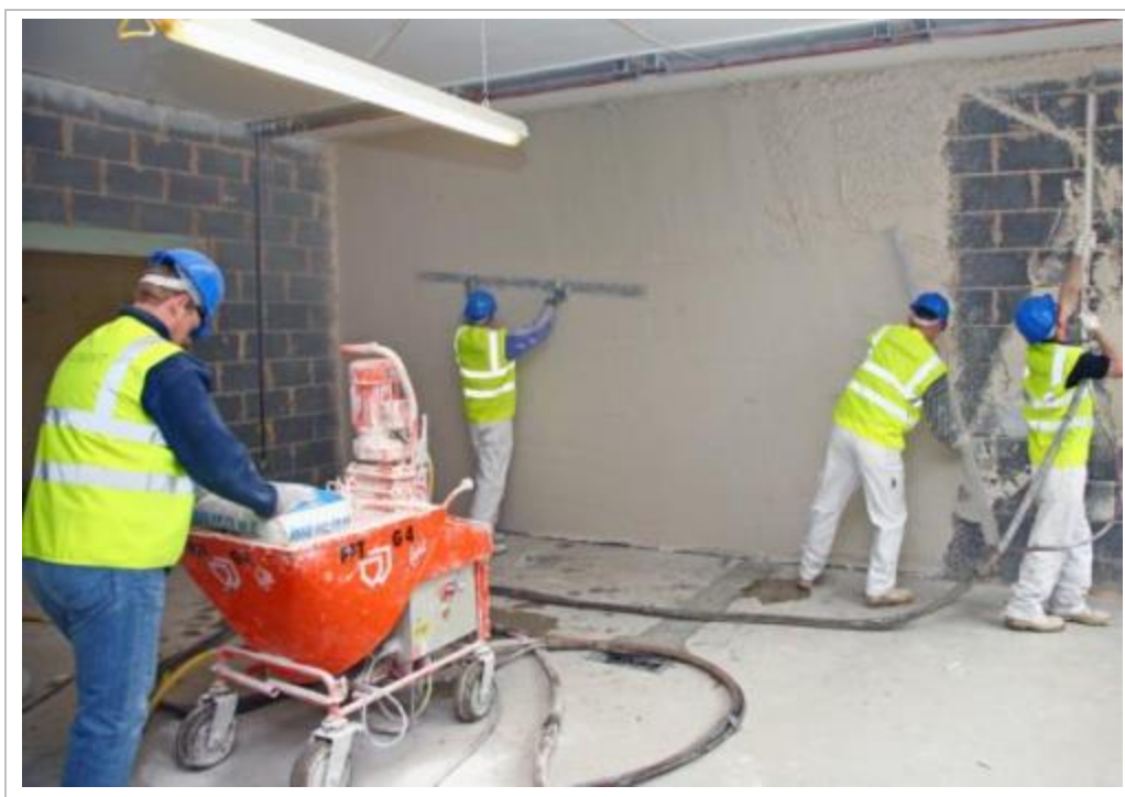
Rysunek 6.2 Wykonywanie mechaniczne tynku
