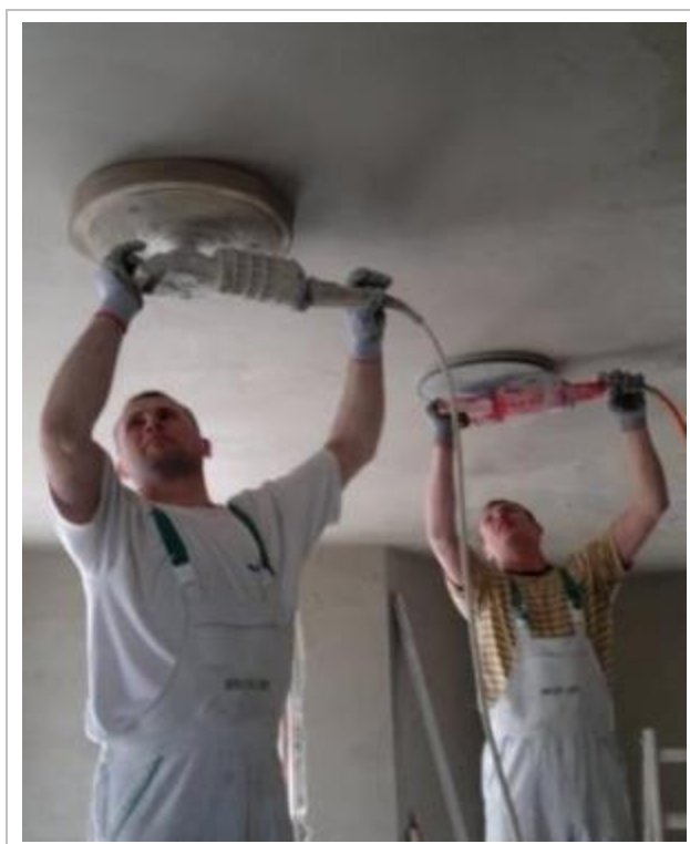
Rysunek 6.3 Mechaniczne zacieranie gładzi
