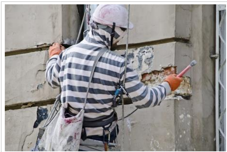
Rysunek 8.2 Zbijanie odparzonego tynku
