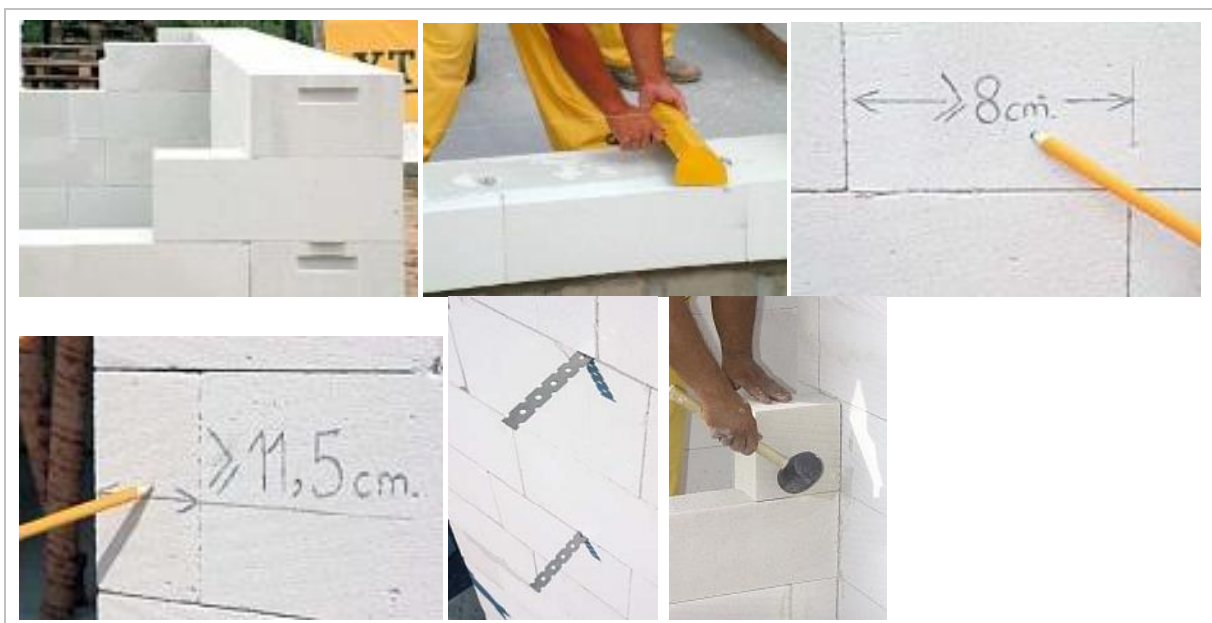
Rysunek 2.10 Murowanie z bloczków z betonu komórkowego
