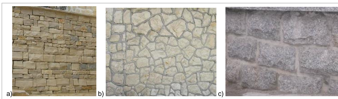
Rysunek 2.4. Mury z kamieni: a) mur warstwowy, b) mur cyklopowy, c) mur z ciosów kamiennych
