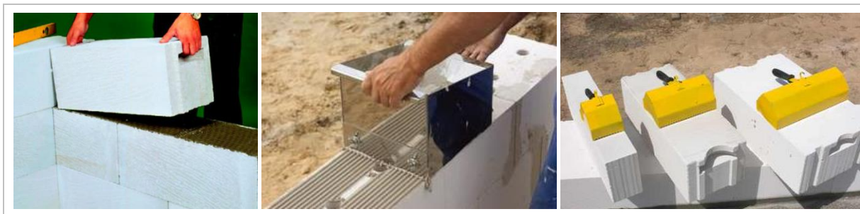
Rysunek 2.16 Murowanie na zaprawy klejowe – dozownik i specjalne kielnie
