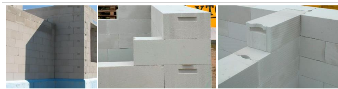
Rysunek 2.3 Mury z bloczków z betonu komórkowego
