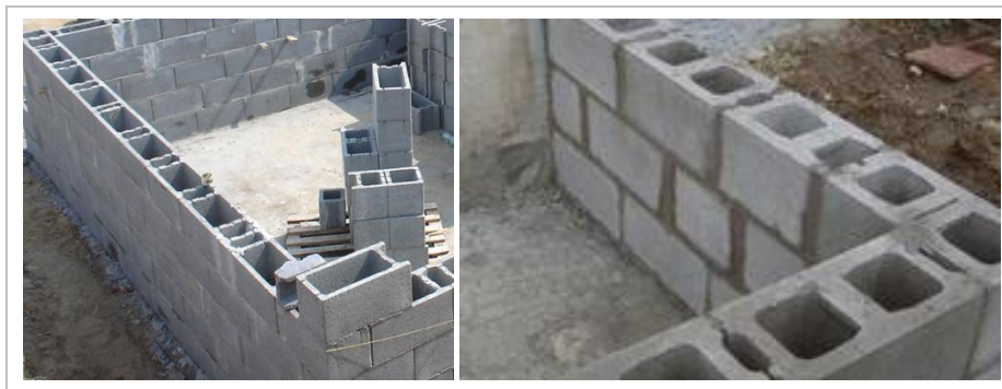
Rysunek 2.1 Mury z pustaków betonowych
