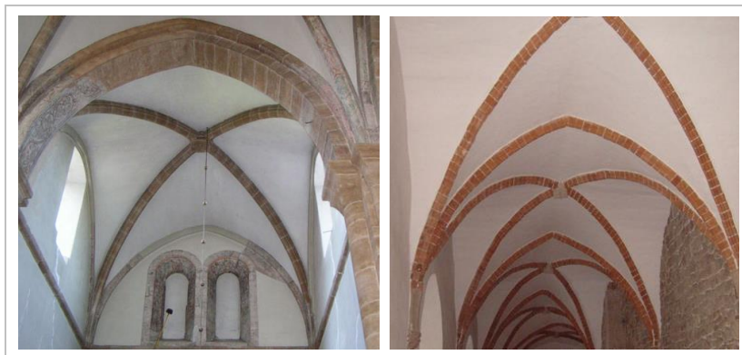
Rysunek 3.16 Sklepienie krzyżowo-żebrowe
